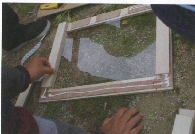
アクリル樹脂板とベニアで窓ユニット (アレンジ仕様)
