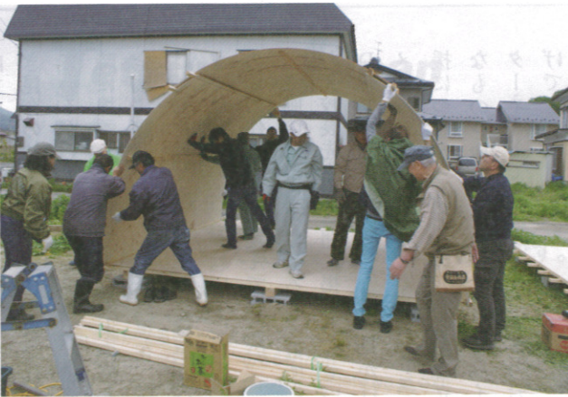
足元を固定してドーム立ち上げに成功
