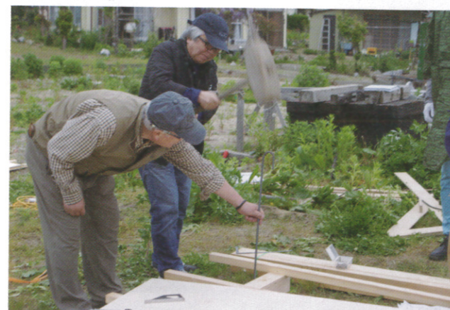
強風対策でアンカーボルトを打ち込む (アレンジ仕様)
