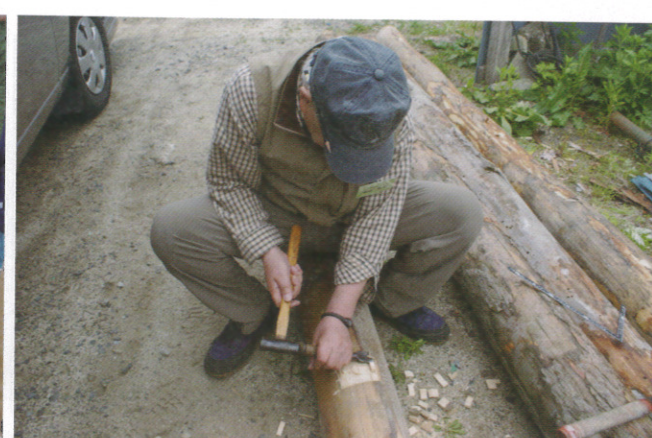
流木丸太をのみ加工し大引の端に載せる (アレンジ仕様)
