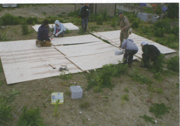
3つを合わせて角材をつなげ防水テープ処理
