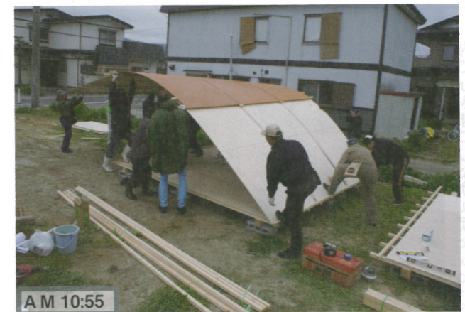
AM 8:31 シハチ6.5mm厚を3枚並べて角材を敷きビス留め
