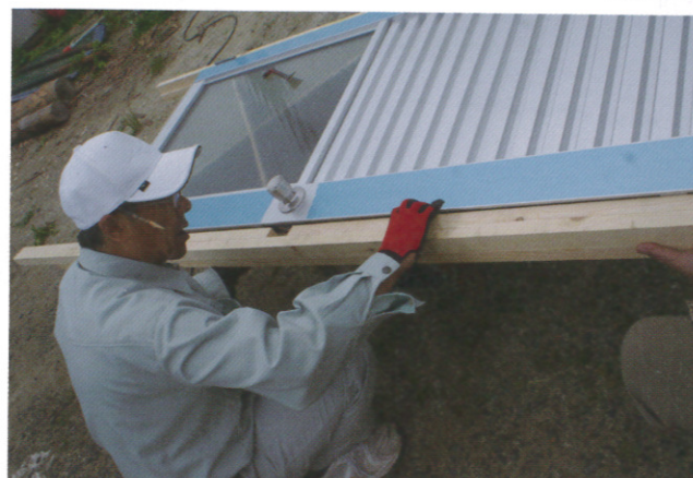
ドア枠を作る 蝶番を取り付けストライクを加工する
