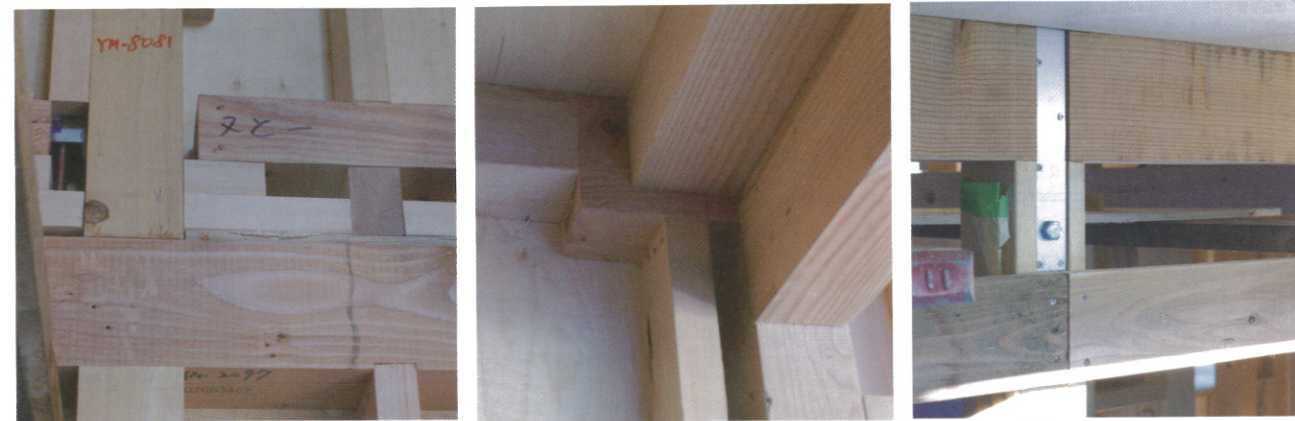
吹き抜けはあて材で調整したり持ち出しで荷重を支えるなど和風建築の要素が見られる 垂木はかど金物やアンカーボルトで緊結
