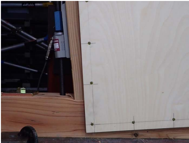
(a) 柱の土台へのめり込み
