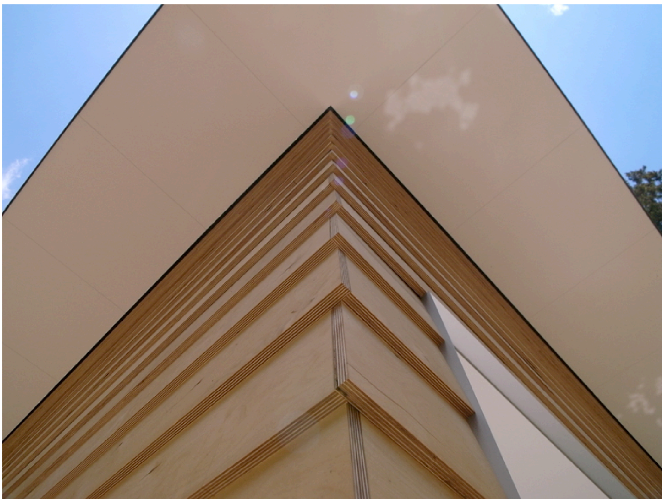
外壁仕上材はエコバーチ合板を使用した。下見張りすることで小口の積層面を見せている。
