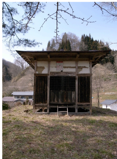
敷地近くにあるお堂。小高い丘の上に象徴的に建っている。
