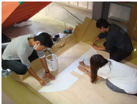
写真2 部材の型取り作業
