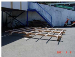
1. 土台(90mm角) 根太45mm角@600の施工
