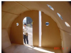
19・ドア枠補強作業中
