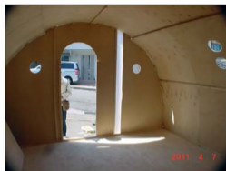
20・内部の補強 30mm 角材の位置に罫目 *この部材を頼りに新熱材や内部造作を取り付け
