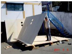
4. 両側面部材を反転し裾用30mm角材を追加 *真ん中のパネルの孔は窓
