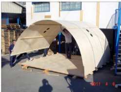
10・ 左端部裾をストッパーブロックに引っ掛けると 建て起こし作業完了。7～10まで10秒！
