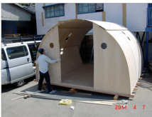
*妻壁を取り付けて完成
