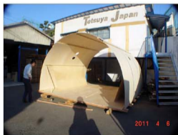
12・ 内部腰部に板補強の合板をセット
