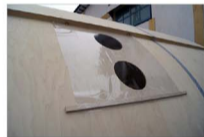
18・窓のビニールカバー（巻き上げ式）
