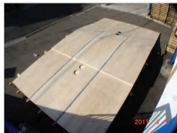
6. 組みあがったドームパネル(3660×6720 約130Kg) *合板接合部には防水テープ貼り
