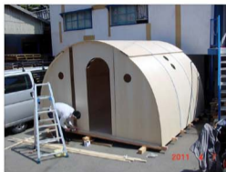
14・ドア回りパネル取り付け。
