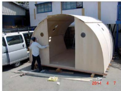
13・妻壁パネルの取り付け（パネルは加工済みまたは型紙支給）
