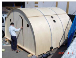
15・ドアパネル（切り出し材）取り付け
